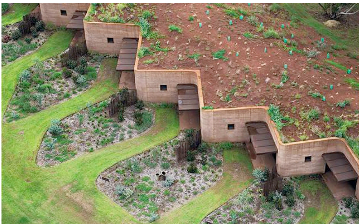
Maisons pour des bergers, réalisées avec des murs en pisé (Australie), projet lauréat du Terra Award
